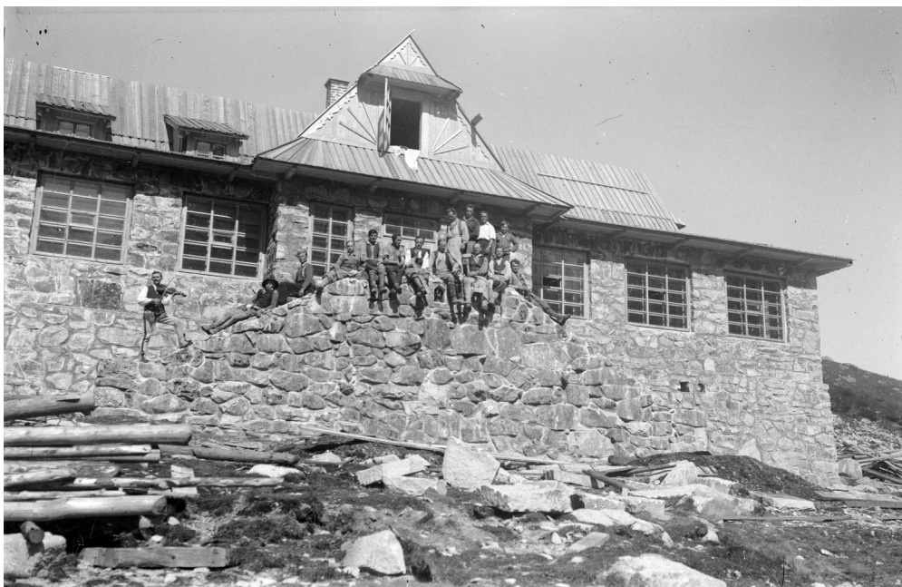
Ilustracja 7. Budynek schroniska w Dolinie Pięciu Stawów Polskich po założeniu kamiennej okładziny. Między 1939 a 1945, fot. M. Tempel. Źródło: NAC, sygn. 2-12042.
