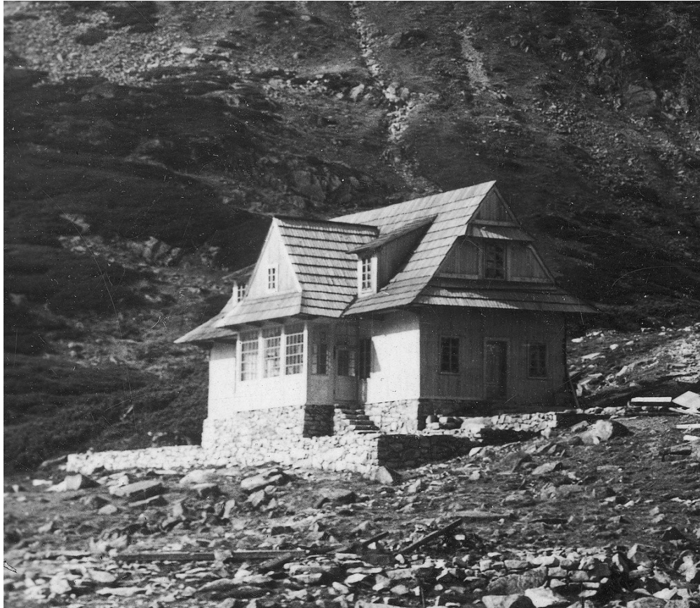
Ilustracja 6. Budynek schroniska w Dolinie Pięciu Stawów Polskich przed założeniem kamiennej okładziny, 1928, fot. A. Jankowski. Źródło: NAC, sygn. 1-S-3766-2.
