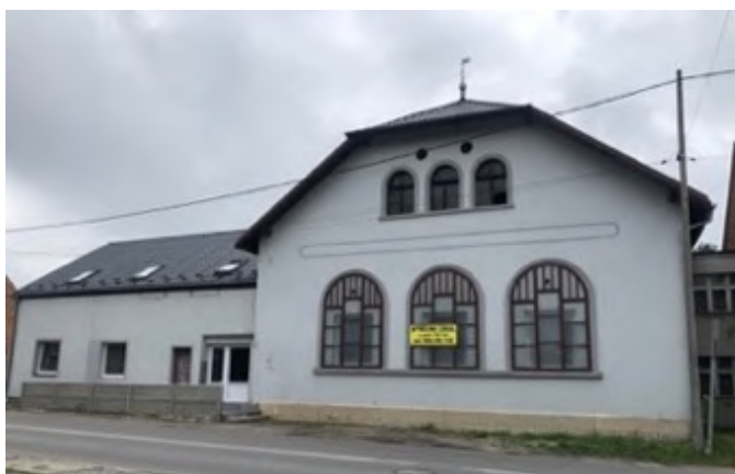
Fot. 29. i 30. Dawna karczma przy ul. Dworcowej 11 w Dziergowicach, zachowano zewnętrzny kształt dawnych otworów okiennych oraz zamontowano osłony nawiązujące podziałami do historycznej stolarki obiektu (E. Mackiewicz)
