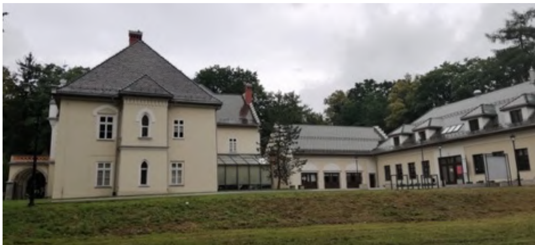
Fot. 18. Dwór w Łodygowicach po renowacji, stan z 2022 r. (M. Godek)
