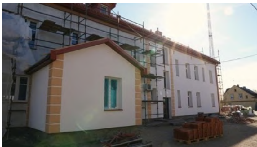
Fot. 8. Elewacja tylna po termomodernizacji, otynkowana z zaznaczonym śladowo boniowaniem
