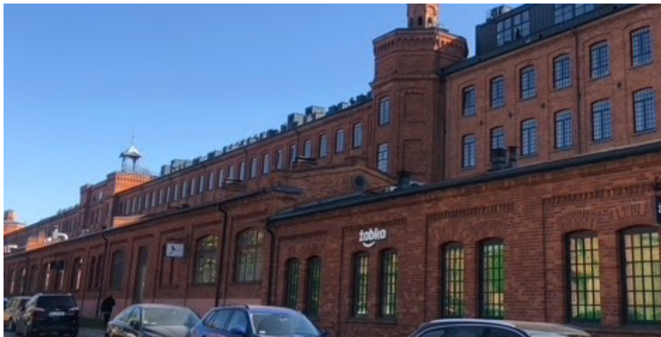
Fot. 32. Klimatyzatory na dachu budynku adaptowanego na cele komercyjne w kompleksie Księży Młyn w Łodzi (E. Mackiewicz)
