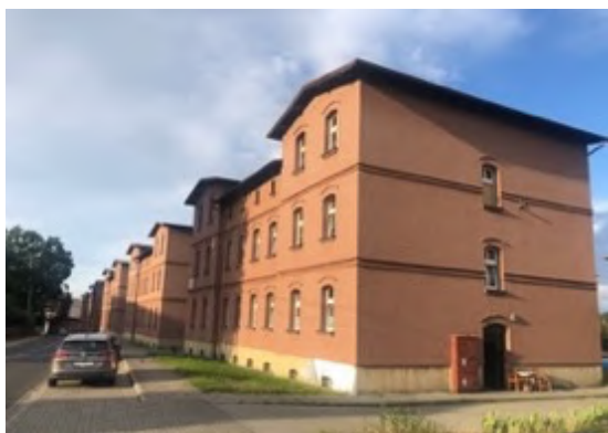
Fot. 9. i 10. Rybnik, osiedle przy ul. Ogrodowskiego – elewacja pokryta płytami styropianowymi oraz tynkiem o rysunku cegły i kamienia z widocznymi ubytkami, (E. Mackiewicz, 8.07.2022)
