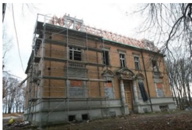
Fot. 118. i 119. Pałac po zdjęciu dawnej konstrukcji dachowej – 2011 (eksploratorzy.com.pl)
