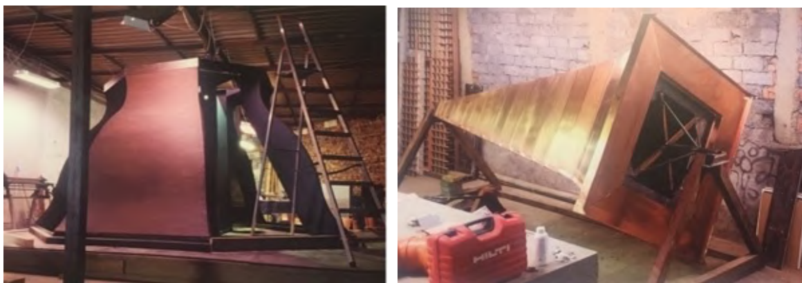
Fot. 126. i 127. Rekonstrukcja kopuły i latarni w warsztacie (2015) (archiwum prywatne rodziny Gładysz)
