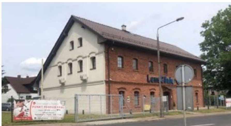
Fot. 13. Docieplenie elewacji szczytowej budynku przy ul. Mikołowskiej w Rybniku (E. Mackiewicz)
