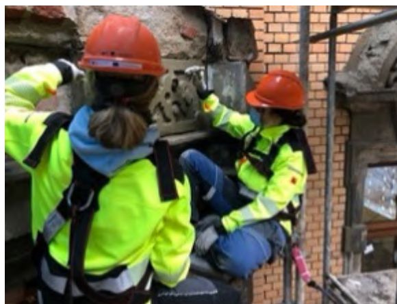
Fot. 139. i 140. Elewacja południowo-zachodnia po renowacji (2021); uczestnicy projektu Czesko-polska szkoła renowacji zabytków podczas oczyszczania detali architektonicznych ryzalitu (2020) (E. Mackiewicz)
