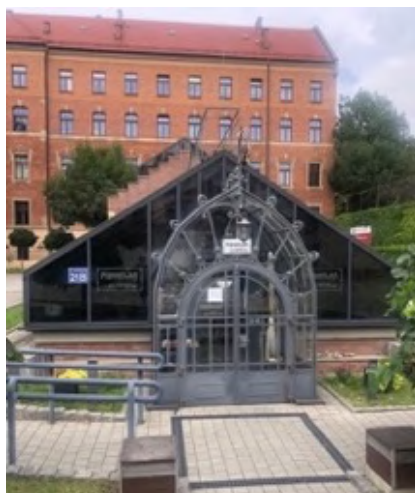
Fot. 52. i. 53. Kawiarnia Pojnarówka w Krakowie, z użyciem szkła fotowoltaicznego wykonano nową zewnętrzną konstrukcję dawnej szklarni z zachowaniem zabytkowych elementów konstrukcyjnych wewnątrz (E. Mackiewicz)
