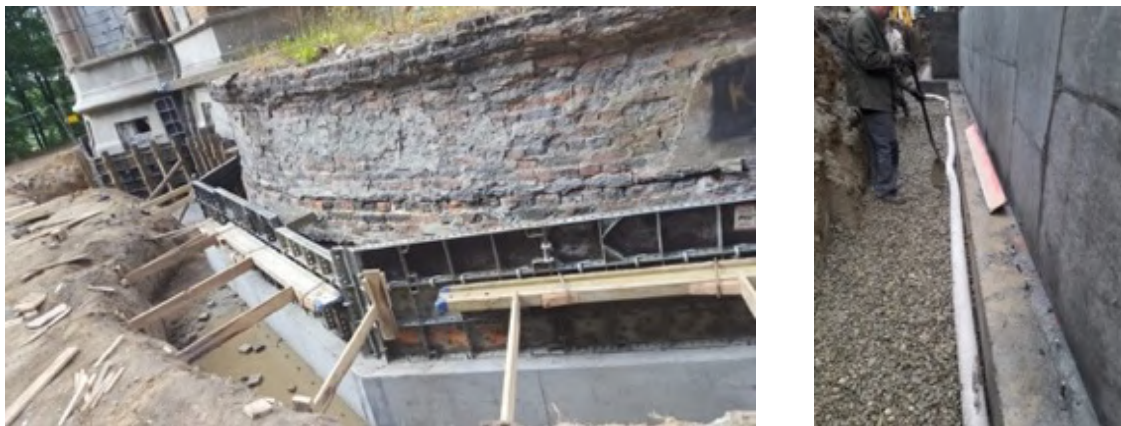
Fot. 38. i 39. Opaska betonowa fundamentów i system odwodnienia wokół palacu w Rzuchowie (J. Gładysz)
