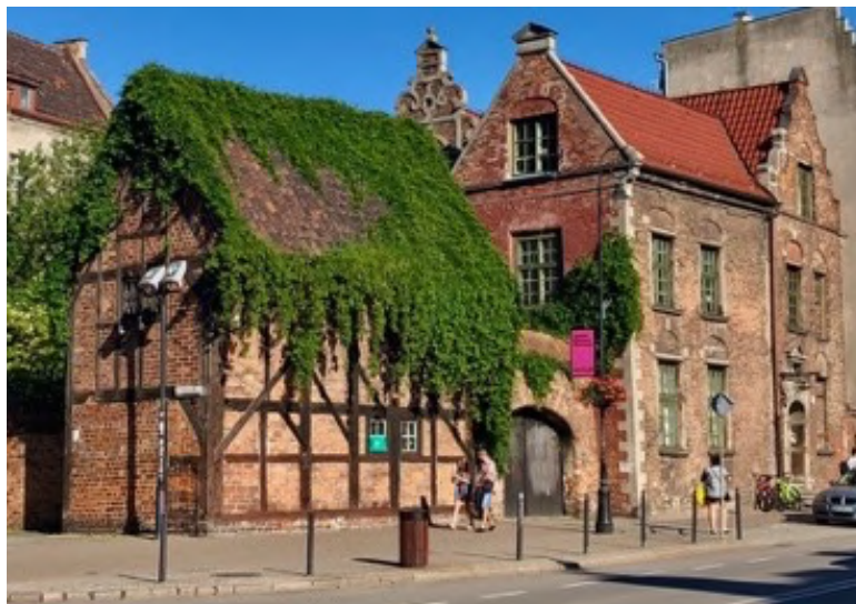
Fot. 59. Gdańsk ul. Podmłyńska/ Katarzynki (E. Mackiewicz)
