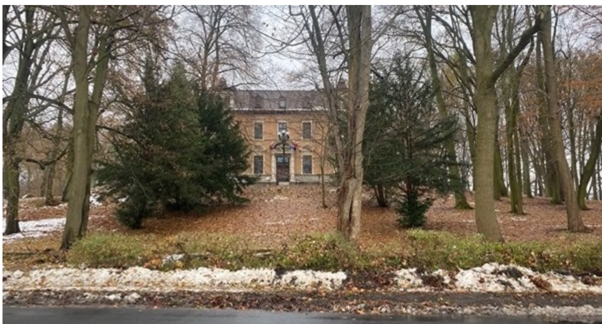
Fot. 148. Elewacja frontowa – oś kompozycyjna 3: północny zachód – południowy wschód, widok od strony szosy (2022) (E. Mackiewicz)
