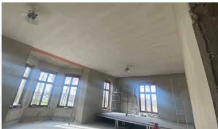
Fot. 155. i 156. Docieplony wełną mineralną strop w sali reprezentacyjnej oraz w wieży (E. Mackiewicz)
