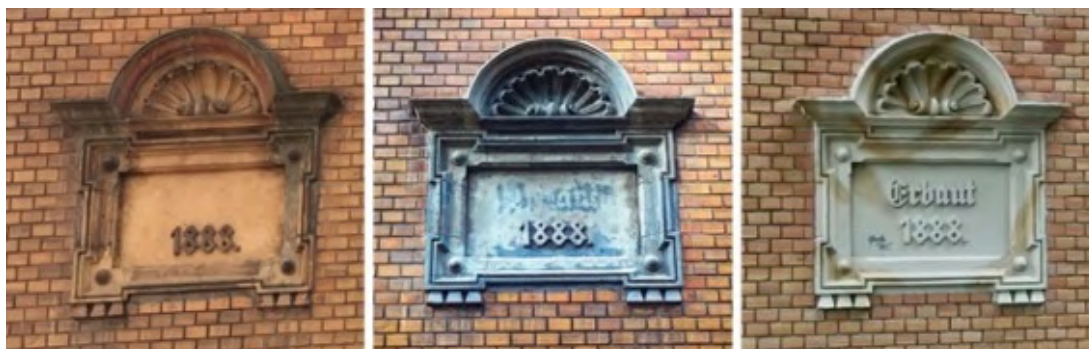
Fot. 94., 95. i 96. Płyцина z datą budowy pałacu przed, w trakcie i po rekonstrukcji w 2018 (E. Mackiewicz)
