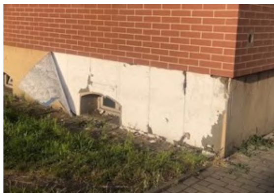
Fot. 9. i 10. Rybnik, osiedle przy ul. Ogrodowskiego – elewacja pokryta płytami styropianowymi oraz tynkiem o rysunku cegły i kamienia z widocznymi ubytkami, (E. Mackiewicz, 8.07.2022)
