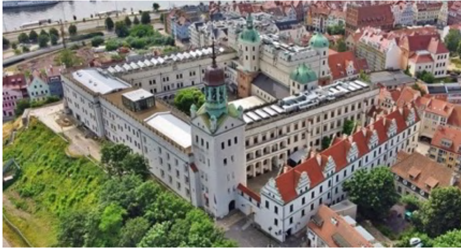
Fot. 31. System wentylacyjny na Zamku Księżąt Pomorskich w Szczecinie, ( https://pl.wikipedia.org/wiki/Zamek_Księżąt_Pomorskich_w_Szczecinie )
