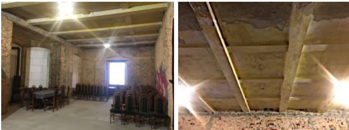
Fot. 109. i 110. Strop żelbetowy w sali reprezentacyjnej i holu na parterze pałacu w Rzuchowie (E. Mackiewicz)
