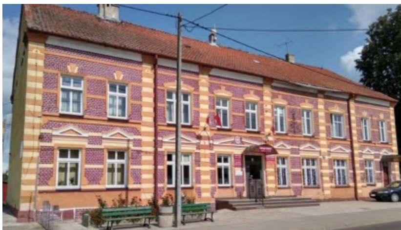
Fot. 5. Elewacja frontowa Urzędu Gminy Banie Mazurskie przed termomodernizacją, ( https://www.whitemad.pl/budynki-urzedu-gminy-w-baniach-mazurskich-znika-pod-warstwa-styropianu/ )
