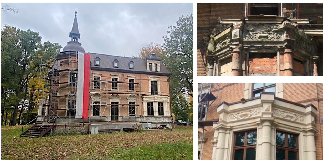
Fot. 141., 142. i 143. Elewacja południowo-wschodnia wraz z wieżą po renowacji (2023); dekoracje ryzalitu w latach 2018 i 2023 (E. Mackiewicz)
