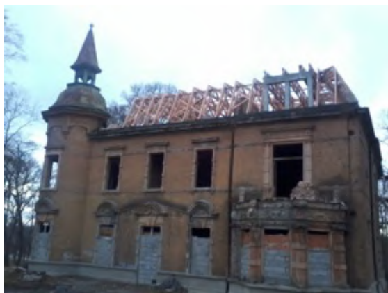
Fot. 120. i 121. Nowa konstrukcja dachu (2012) (J. Gładysz, A. Król)
