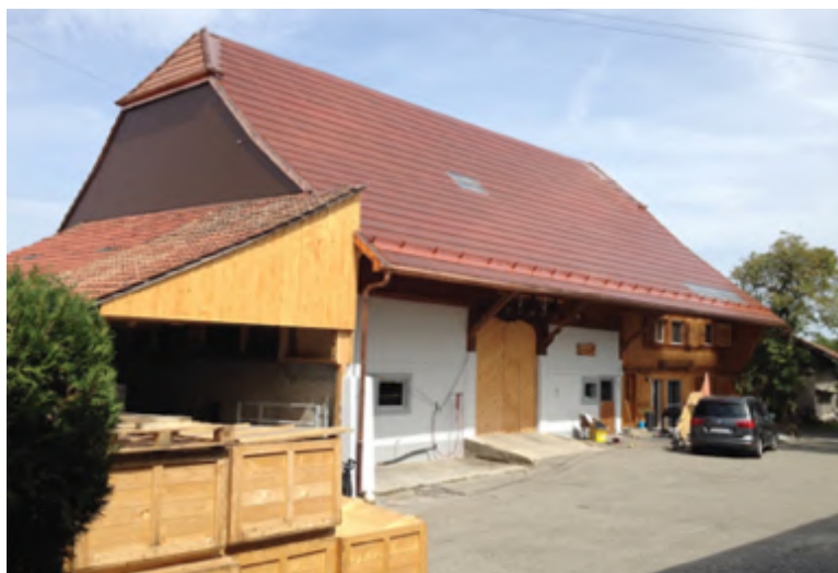
Fot. 51. Szwajcaria, pilotażowy projekt zastosowania dachówki fotowoltaicznej na dachu wiejskiego domu z 1859 r. ( https://solararchitecture.ch/rural-house-galley/ )
