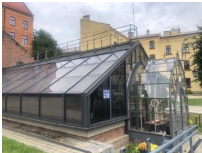
Fot. 52. i. 53. Kawiarnia Pojnarówka w Krakowie, z użyciem szkła fotowoltaicznego wykonano nową zewnętrzną konstrukcję dawnej szklarni z zachowaniem zabytkowych elementów konstrukcyjnych wewnątrz (E. Mackiewicz)
