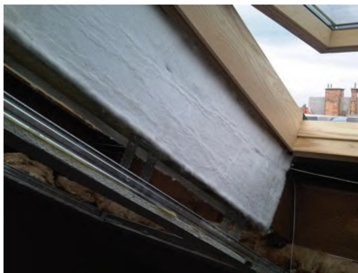
Fot. 15. Docieplenie matą z aerożelu ościeża okna dachowego
