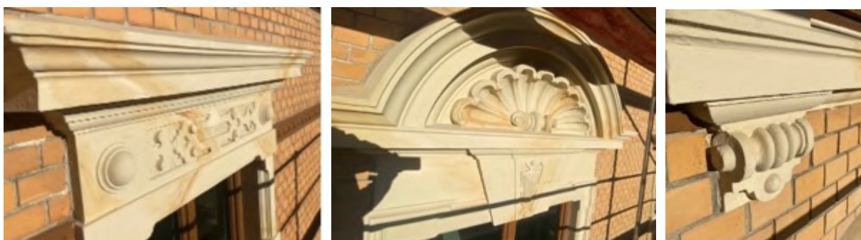
Fot. 97., 98. i 99. Detale obramowań okiennych po renowacji (2023) (E. Mackiewicz)
