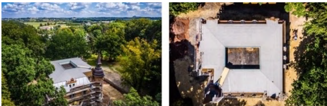
Fot. 153. i 154. Wewnętrzny taras dachowy przygotowany do montażu zewnętrznych elementów systemu rekuperacji (M. Giba)
